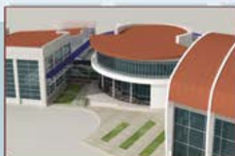
ساختمان آموزشی پردیس بهشهر
