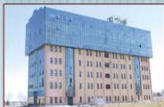
ساختمان دانشکده کارخانه نیرومحرکه
